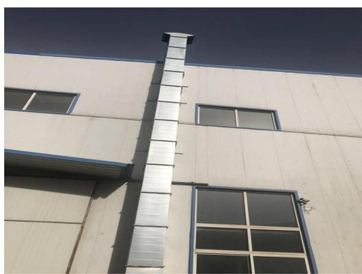
电机浸漆和烘干废气UV光氧催化处理设施及排气筒
